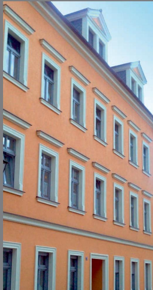
Foto: Rahmenprofile und Verzierungen für Fenster und Türen an einem denkmalgeschutzgerecht sanierten Gebäude in Kamenz
