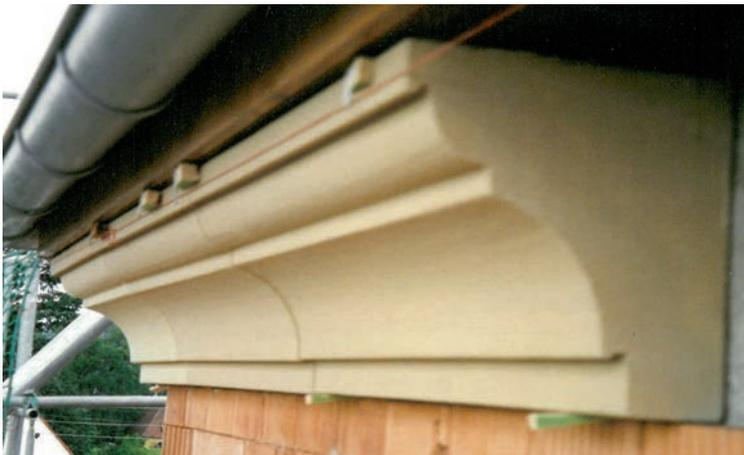
Foto: Anbau von Traufgesimsen an einer Fassade
